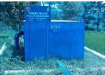
Gambar 3.14 Bak Pelepas Tekan (BPT)
